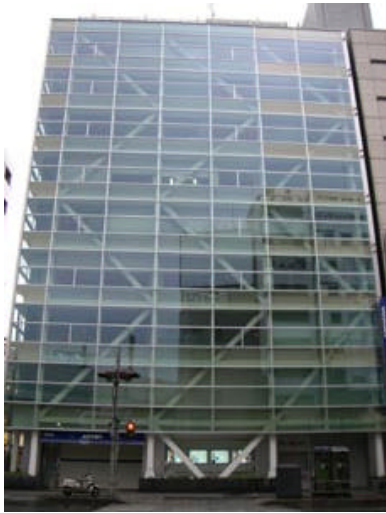
株式会社セピア < 施工 :ピットスリー >
