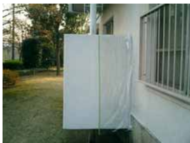
2003年洗浄後左半分施工
