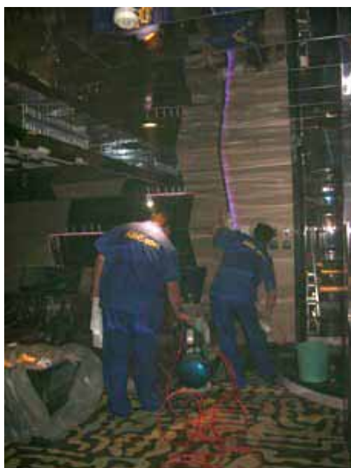
北京のディスコの施工工事
