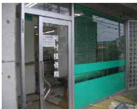
河村接骨院(ベロモンド施工)
