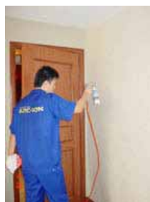
(北京の女優の家を施工している写真)
