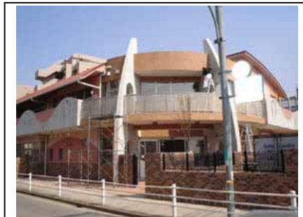
兵庫県の保育園の施工
